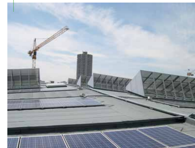
Panneaux photovoltaïques sur le toit de la halle d'athlétisme
