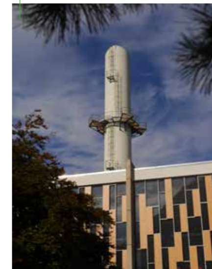
Chauffage urbain biomasse
