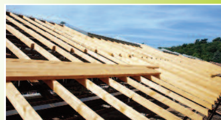
Charpente sous toiture B03. 15-07-2011
