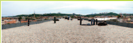
Toit terrasse du B02 le 15-07-2011
