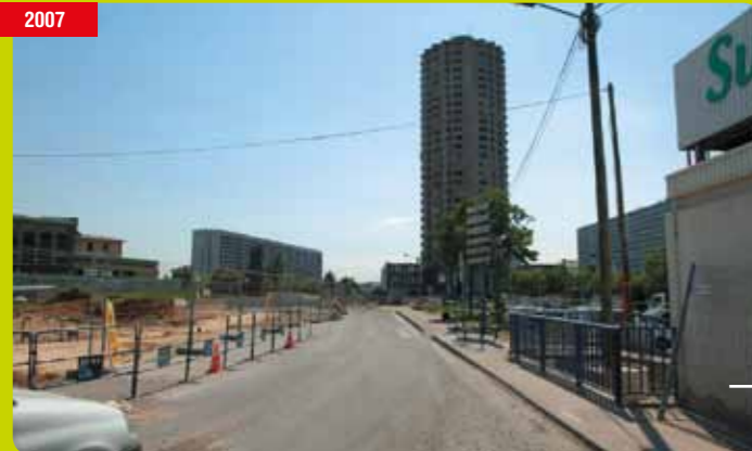
Le mur d'enceinte du lycée a disparu.
