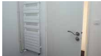
Les logements réaménagés
