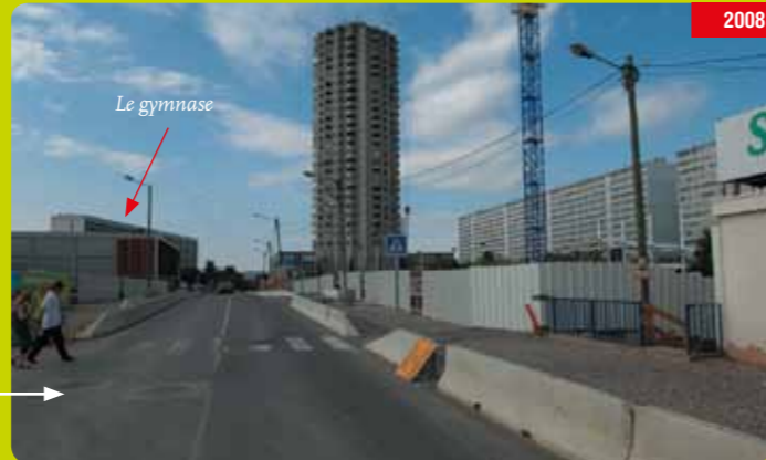
Le nouveau gymnase a été livré.
